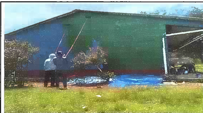
FOTO 3: SUSTITUCION DE PINTURA EN GENERAL
