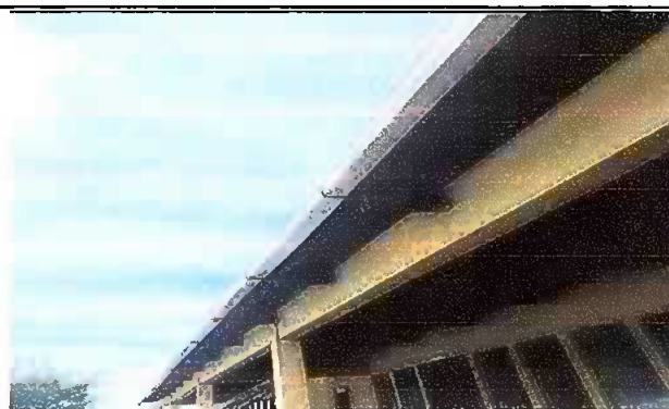
Foto 4: Modulo 3. Canales de pvc 24 m. lineales
