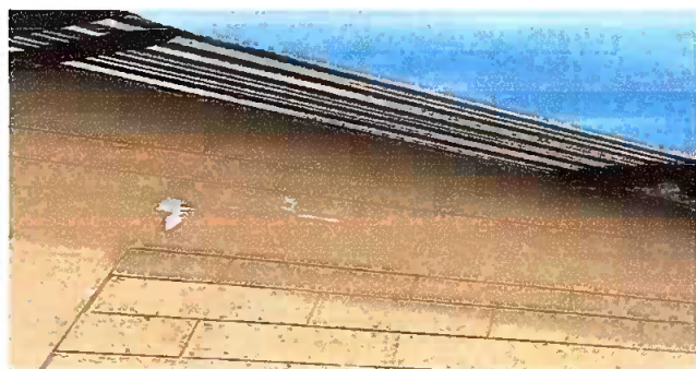
Foto 3: Modulos 3 lamina, por lamina estrella calibre 28
