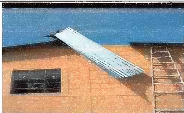
Foto 3: Modulos 3 colocación de lamina, por lamina estrella calibre 28
