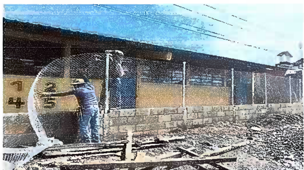
Foto1: instalacion de malla petimetral.
