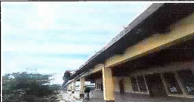
Foto 4 Modulo 3 Sustitucion de canales de pvc amanco de 24 m.
