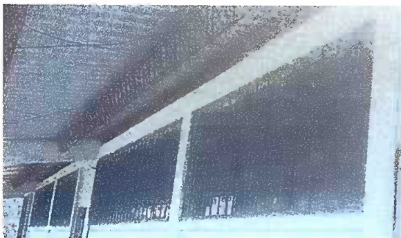
Foto1: MODULO 1. Sumnistro e instalacion de balcon de hierro en ventana.
