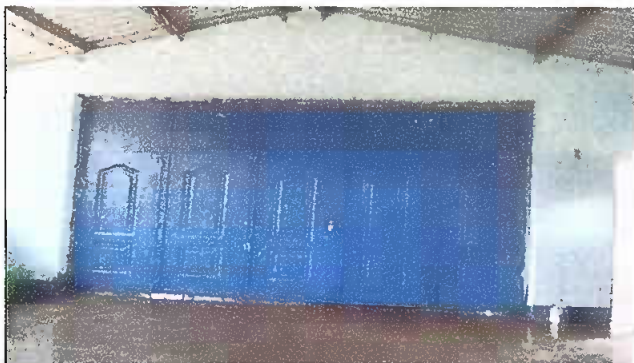
Foto 3: MODULO 1. Sustitucion de muro divisorio plegable de metal.
