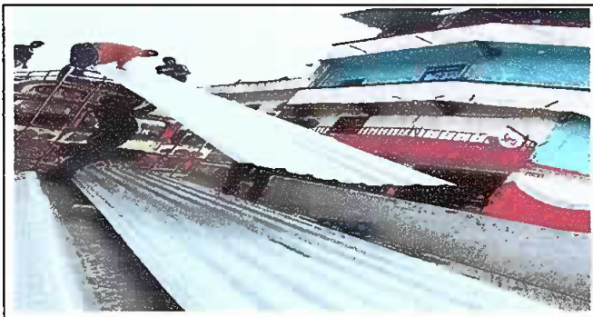
Foto 6: MODULO 1. Sustitucion de laminas, por lamina troquelada aluzinc calibre 26
