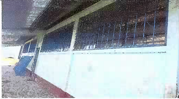
Foto1: MODULO 1. Sumnistro e instalacion de balcon de hierro en ventana.
