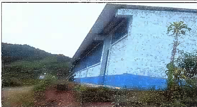
Foto 8: Pintura en muros exteriores e interiores.
