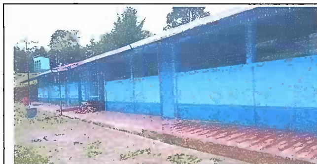
FOTO 4: APLICACIÓN DE PINTURA
