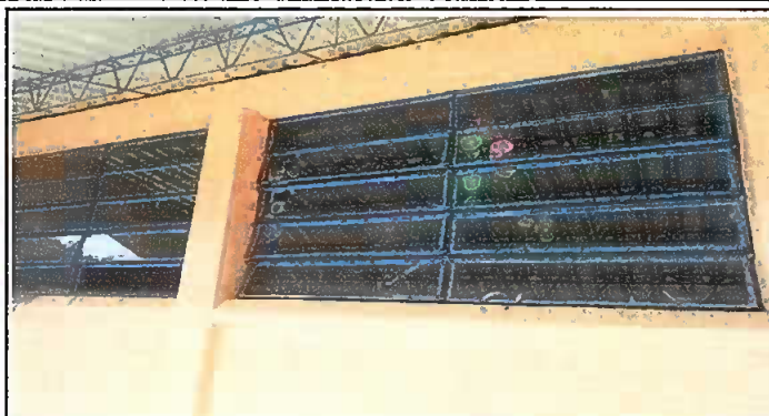
FOTO 2: MODULO 1, SUSTITUCIÓN DE VIDRIOS.
