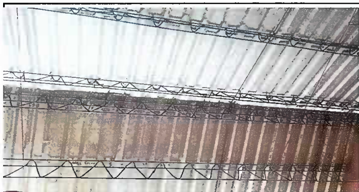
FOTO1: MODULO 1, SUSTITUCIÓN DE LAMINAS, CAPOTES Y ELEMENTOS DE FIJACIÓN.
