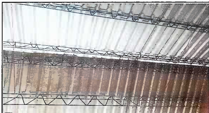
FOTO 4: MODULO 1, DESINTALACIÓN DE LAMINAS.
