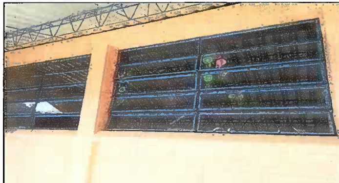
FOTO 2: MODULO 1, SUSTITUCIÓN DE VIDRIOS.
