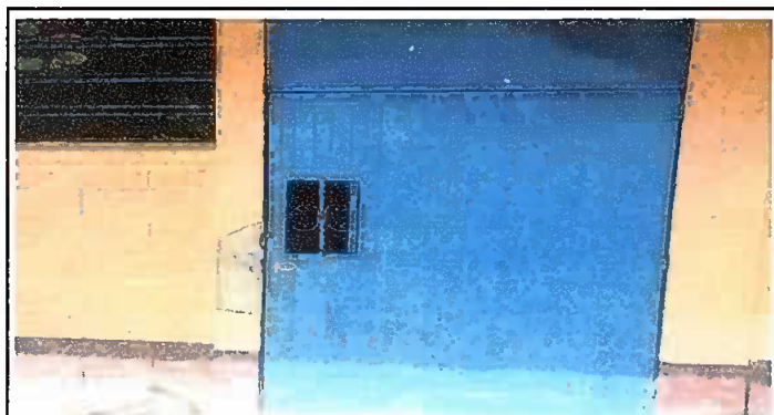
FOTO 3: MODULOS 1, SUSTITUCIÓN DE PUERTAS.
