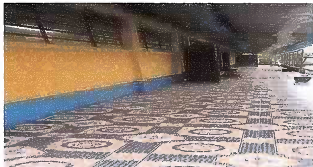
FOTO 1: MODULO 1, SUSTITUCION DE PISO DE TORTA DE CONCRETO POR PISO CERAMICO
