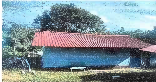
BODEGA 2. Sustitucion de laminas por lamina troquelada y sustitucion de puerta.
