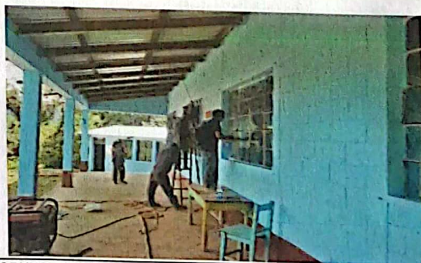
MODULO 1. Sustitucion de Vidrios-
