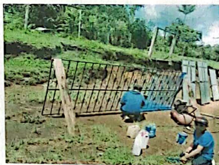
DIRECCION 4. Suministro y instalacion de balcon
