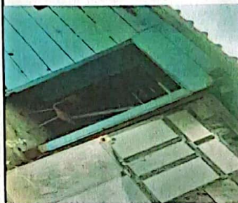
BODEGA 2. Sustitucion de laminas por lamina troquelada y sustitucion de puerta.
