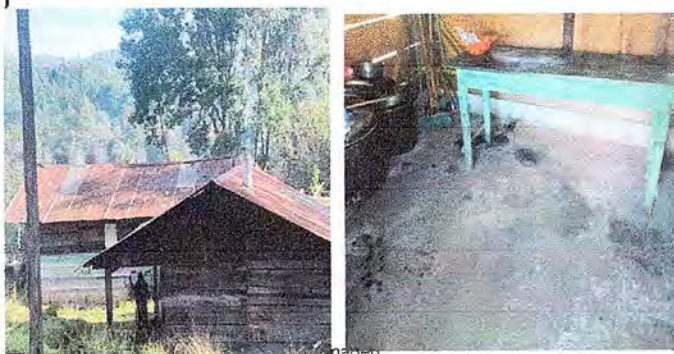
Foto1: COCINA: Sustitución de lámina, por lámina troquelada aluzinc calibre 26
