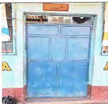
Foto 5: MODULO 1 sustitucion de las puertas de las aulas de metal.
