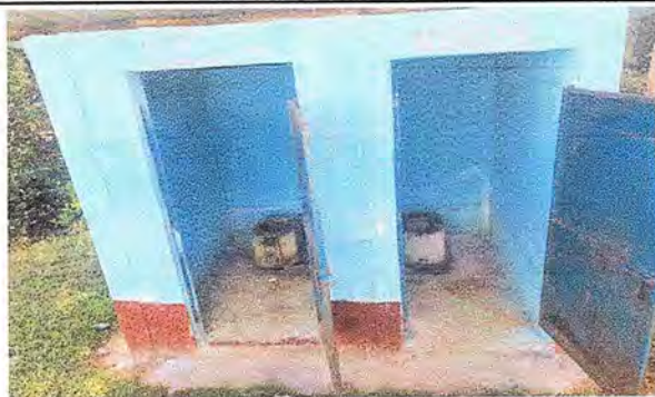
Foto 3: BAÑOS: sustitucion de las puertas de los baños.
