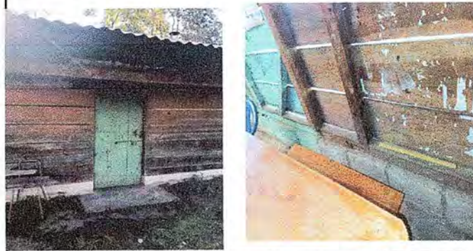
Foto 2: BODEGA: Sustitución de lámina por lámina troquelada aluzinc calibre 26
