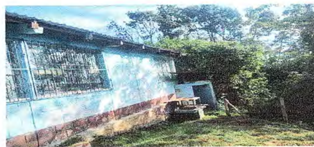
Foto 6.MODULO 1 Pintura de las aulas.
