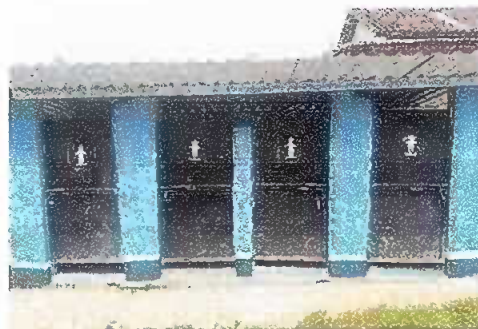
Foto 18 Módulo 3 Pintura en muros exteriores e interiores
