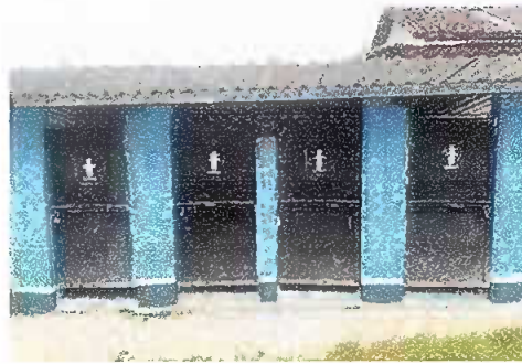
Foto 16 Módulo 3 sustitución de estructura de soporte de madera, por metal
