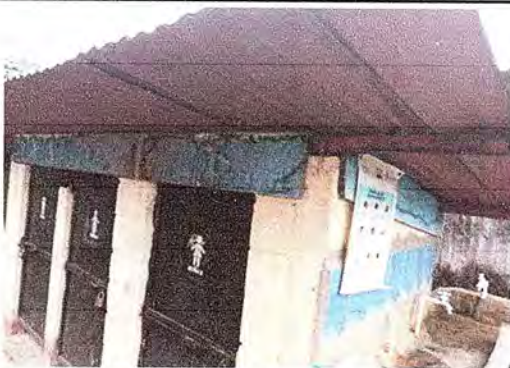
Foto 15 Modulo 3 Sustitucion de lamina, por lamina troquelada aluzinc calibre 26
