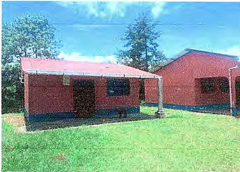
Foto 7 Modulo 1 Instalacion de lamina existente.
