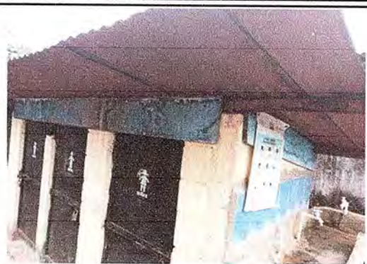
Foto 14 Modulo 3 Sustitucion de elementos de fijacion (tornillos)
