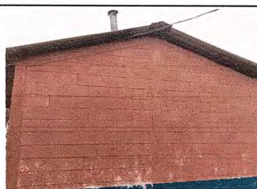
Foto 4 Modulo 1 Pintura en muros exteriores e interiores
