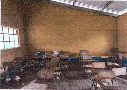
Foto 13 Modulo 2 Pintura en muros exteriores e interiores
