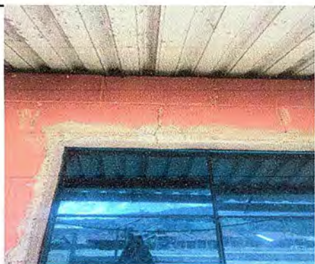
Foto 3 Modulo 1 sustitucion de canal de pvc
