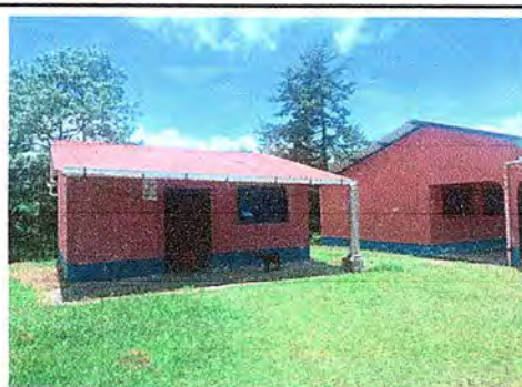
Foto 6 Modulo 1 Desinstalacion de lamina existente
