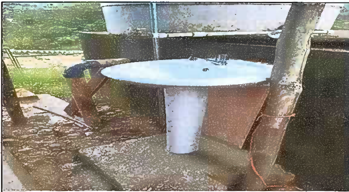
Foto 3: Modulo 1 Suministro e instalación de lavamanos
