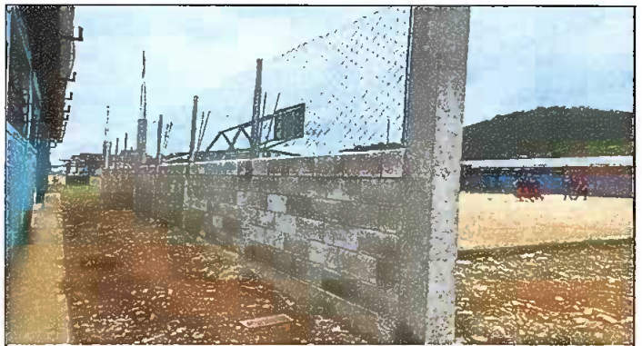
Foto 4: CANCHA Reparación de muro perimetral de block con tubo hg y malla galvanizada, soleras intermedias y columnas
