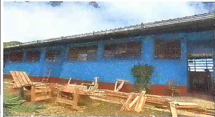
Foto1: Modulo 1 Suministro e instalación de balcon de hierro en ventana
