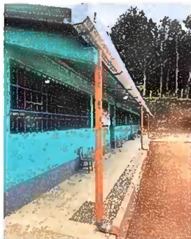
Modulo 1: Foto 1 sustitucion de canales y bajadas de agua.
