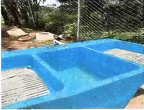
Modulo 3: Foto 13 Sustitucion de pila de cemento
