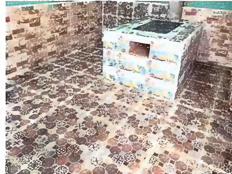
Modulo 2: Foto 8 Sustitucion de torta de cemento a piso ceramico
