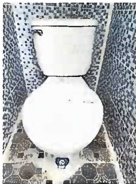
Modulo 3: Foto 9 Sustitucion de letrinas a baños lavables
