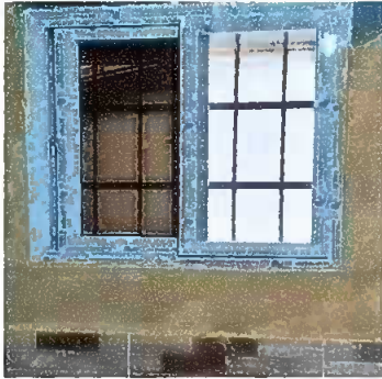
Modulo 2: Foto 7 Sustitucion de ventanas a pvc
