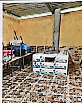
Modulo 2: Sustitucion de torta de cemento a piso ceramico
