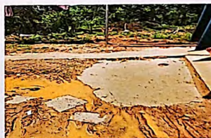
Modulo 3: Sustitucion de torta de concreto
