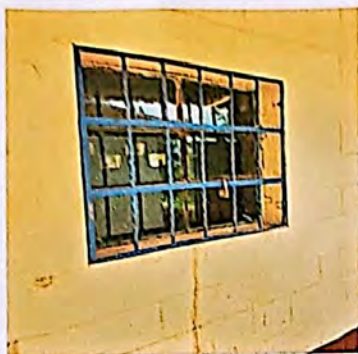
Modulo 2: Sustitucion de ventanas a pvc
