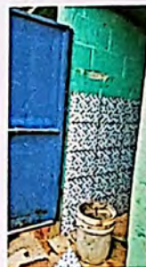
Modulo 3: Sustitucion de torta de cemento a piso ceramico y azulejo en muros interiores
