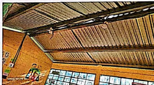
Modulo 1: reparacion de sistema electrico
