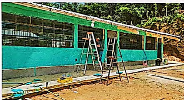
Modulo 1: pintura en muros exteriores
