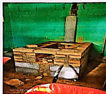
Modulo 2: Reparacion de estufa rural
