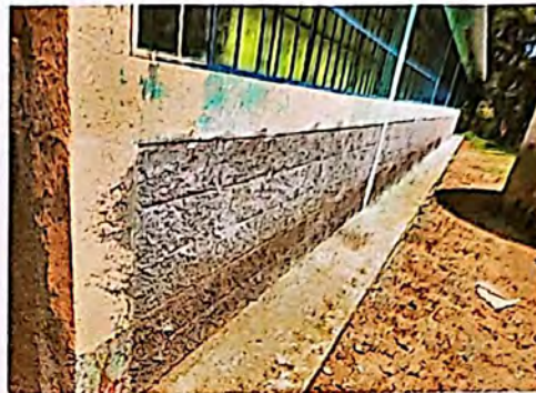
Modulo 1: repello de muro exterior
