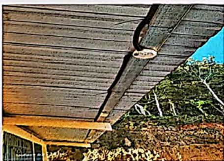
Modulo 1: Reparacion de sistema electrico
