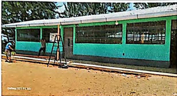
Modulo 1: sustitucion de canales y bajadas de agua.
