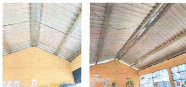
Modulo 1: Foto 4 reparacion de sistema electrico
