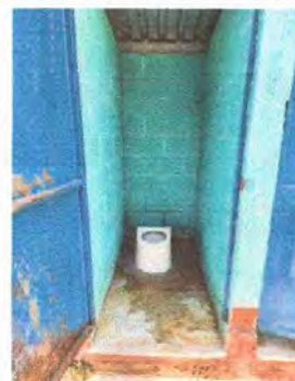
Modulo 3: Foto 10 Sustitucion de torta de cemento a piso ceramico y azulejo en muros interiores
