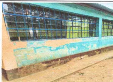
Modulo 1: Foto 3 pintura en muros exteriores
