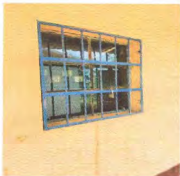
Modulo 2: Foto 7 Sustitucion de ventanas a pvc
