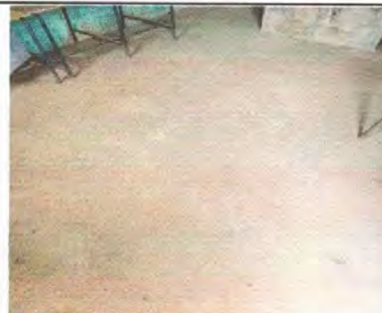
Modulo 2: Foto 8 Sustitucion de torta de cemento a piso ceramico
