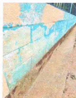
Modulo 1: Foto 2 repello de muro exterior
