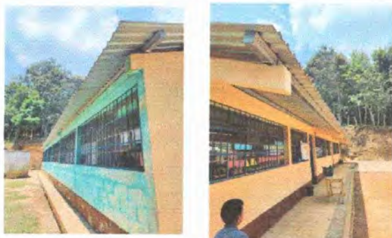
Modulo 1: Foto 1 sustitucion de canales y bajadas de agua.
