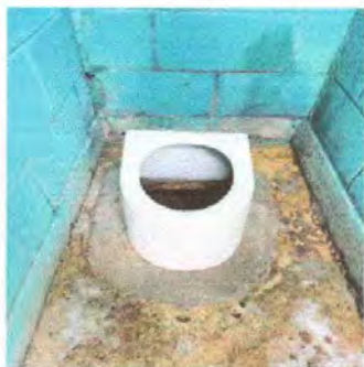
Modulo 3: Foto 9 Sustitucion de letrinas a baños lavables
