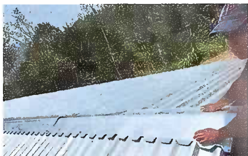
Módulo 2: Sustitución de capote de lámina para lámina troquelada
