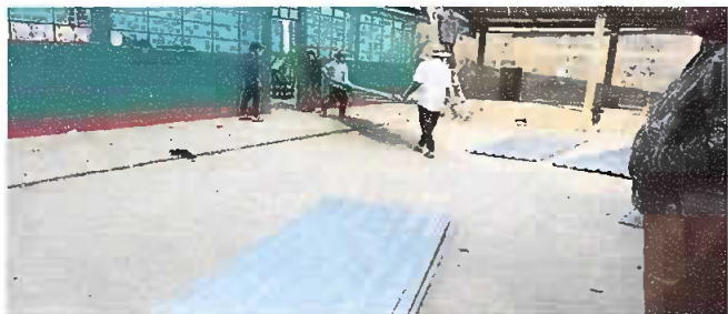
Módulo 1: Sustitución de lámina, por lámina troquelada aluzinc calibre 26
