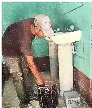
Módulo 3: Instalación de lavamanos
