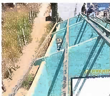
Módulo 2: Desinstalación de lámina existente
