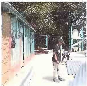
Módulo 1: Sustitución de capote de lámina para lámina troquelada
