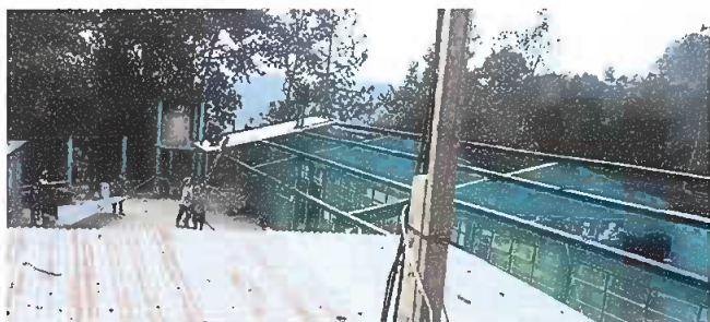
Módulo 2: Sustitución de lámina, por lámina troquelada aluzinc calibre 26
