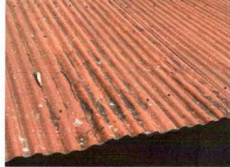
Módulo 1: Desinstalación de lámina existente
