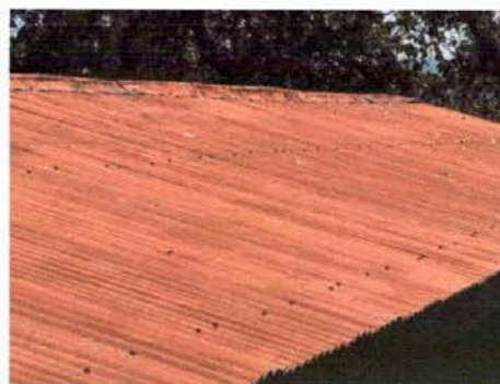
Módulo 2: Desinstalación de lámina existente
