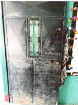
Módulo 1: Fabricación o instalación de puerta metal
