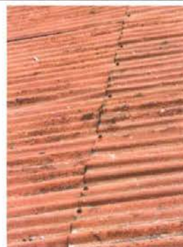
Módulo 1: Sustitución de elementos de fijación
