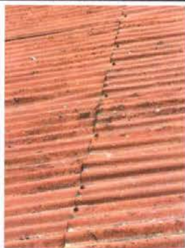
Módulo 2: Sustitución de elementos de fijación
