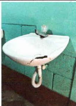
Módulo 3: Sustitución lavamanos
