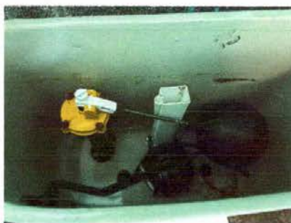
Módulo 3: Cambio de accesorio de sanitario
