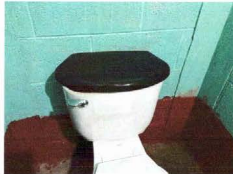
Módulo 3: Cambio de tapadera de sanitario
