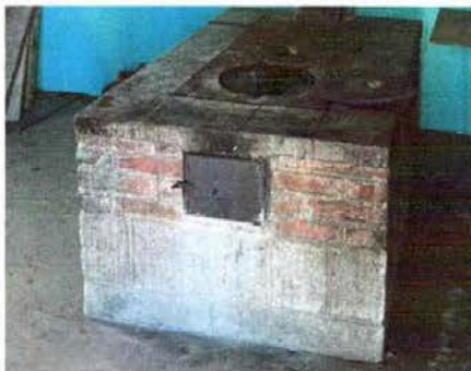
Módulo 2: Instalación de azulejo en estufa rural
