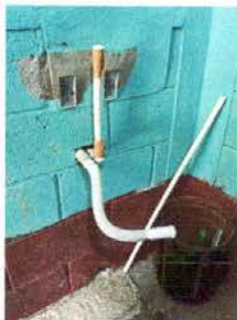
Módulo 3: Instalación de lavamanos
