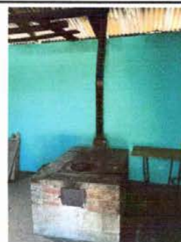
Módulo 2: Mantenimiento a estufa rural
