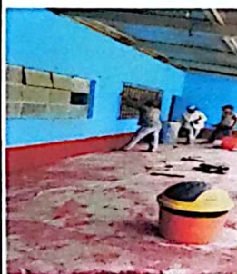
Foto 4: Mantenimiento a balcones de metal.
