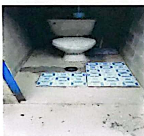
Foto 1: Mantenimiento a reposadera, Sustitución accesorios inodoro (contra llave, tubo de abasto.) y Sustitución de piso cerámico.
