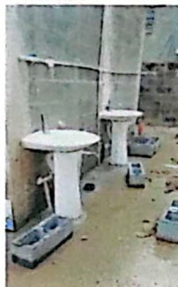
Foto 2: Sustitución de lavamanos (contra llave, tubo de abasto.) y mantenimiento de drenaje.
