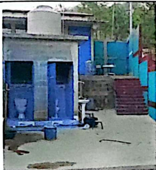
Foto 3: Sustitución de barandas de metal, sustitución de maya galvanizada y pintura.
