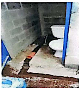
Foto 1: Mantenimiento a reposadera, Sustitución accesorios inodoro (contra llave, tubo de abasto.) y Sustitución de piso cerámico.
