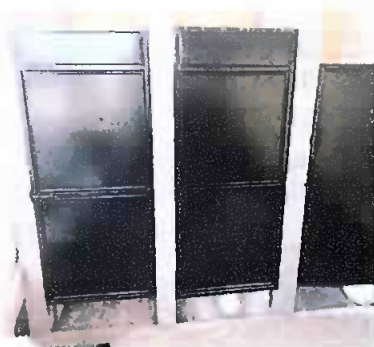
Colocacion de puertas
