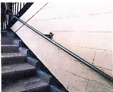
Fabricacion de pasamanos para gradas
