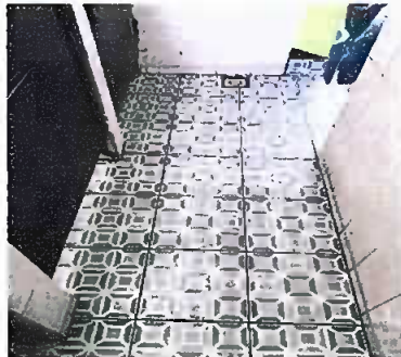
Sustitucion de piso de granito, por piso ceramico
