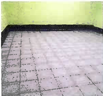
Sustitucion de piso de torta de concreto
