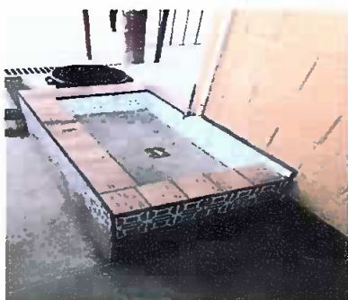
Fabricación y forrado de pileta con azulejo
