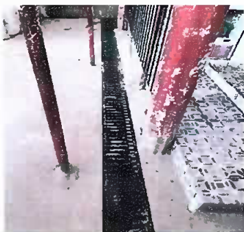
Reparación de cuneta de concreto
