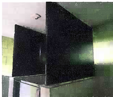
Fabricacion e instalacion de division de metal
