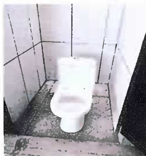
Instalacion de baños
