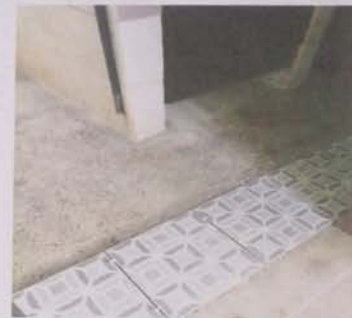
Sustitucion de piso de granito po piso ceramico
