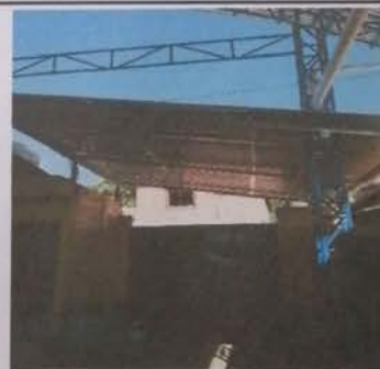
Instalacion de lamina troquelada
