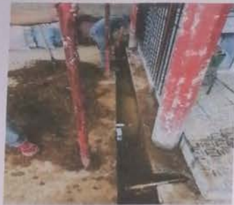
Reparacion de cuneta de concreto
