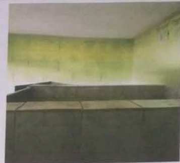
Fabricacion e instalacion de division de metal
