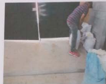
Fabricacion de rampa de concreto
