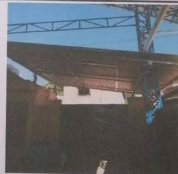
Instalacion de lamina troquelada
