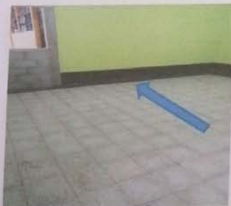
Demolicion de grada de concreto
