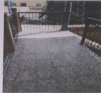
Sustitucion de piso de torta de concreto
