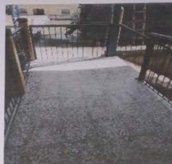
Sustitución de piso de torta de concreto
