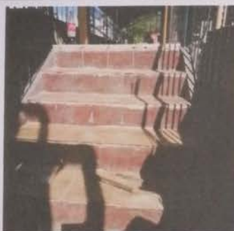
Sustitución den piso de torta por ceramica
