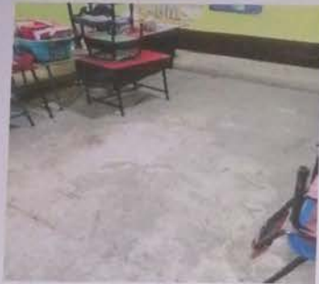
Sustitución den piso de torta de concreto
