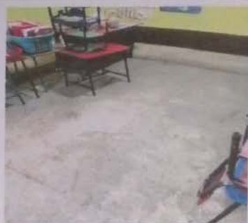
Sustitución den piso de torta de concreto
