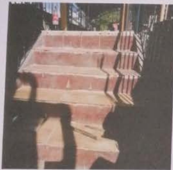
Sustitucion den piso de torta por ceramica
