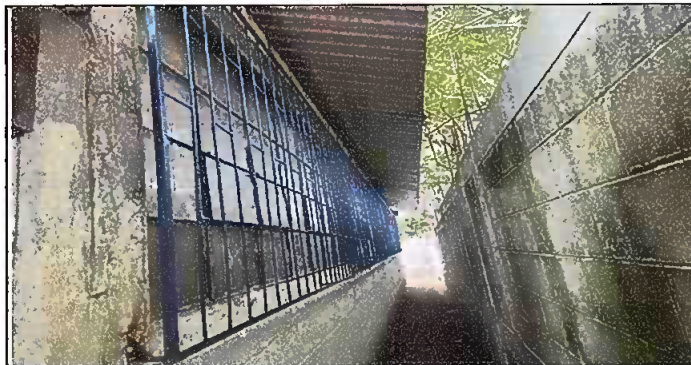
Modulo 4: Suministro de Balcones a 2 aulas
