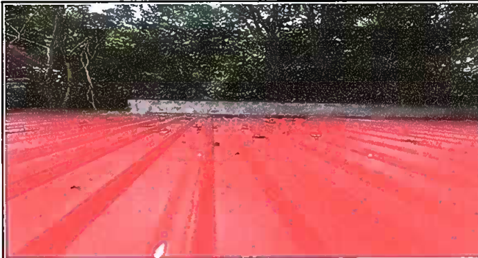
Módulo 1: Sustitución de lamina a lamina Troquelada calibre 26
