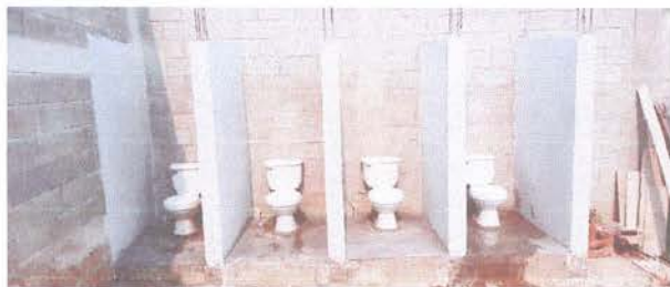
Foto 7: Sustrución de tazas para servicios sanitarios en módulo 4
