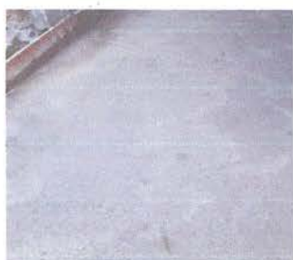
Foto 3: Sustitución de piso cerámico en módulo 2
