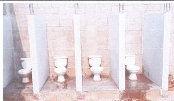
Foto 6: Sustitución de puertas de baños en módulo 4
