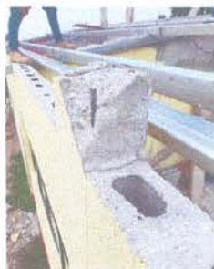
Foto 1: Sustitución de lamina y estructura portante en el módulo 1
