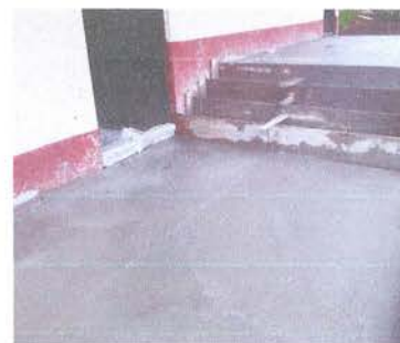
Foto 2: Sustitución de piso de concreto en el módulo 1
