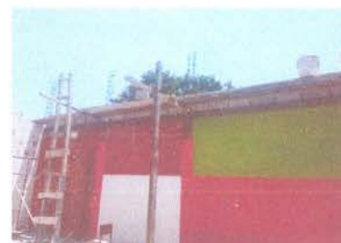
Foto 4: Sustitución de piso de concreto en modulo 3
