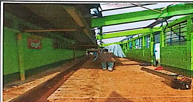
Foto 3: Eliminación de Lámina dañada y mantenimiento a costaneras y fijaciones.
