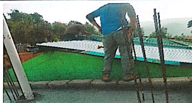
Foto 2: Instalación de lámina troquelada y sus respectivas fijaciones
