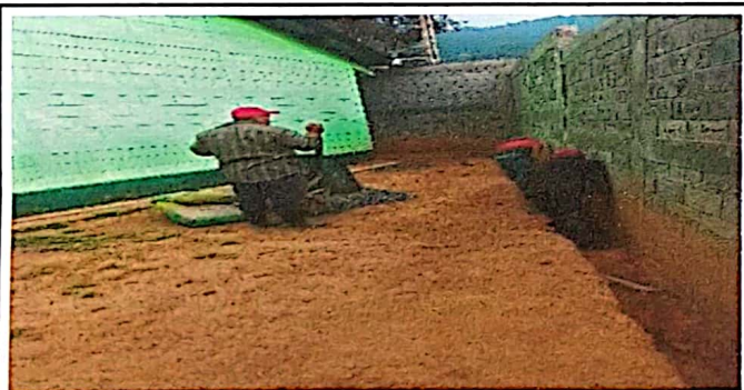
Foto 5: Construcción de sanjeado para la elaboracion de cunetas de aguas pluviales
