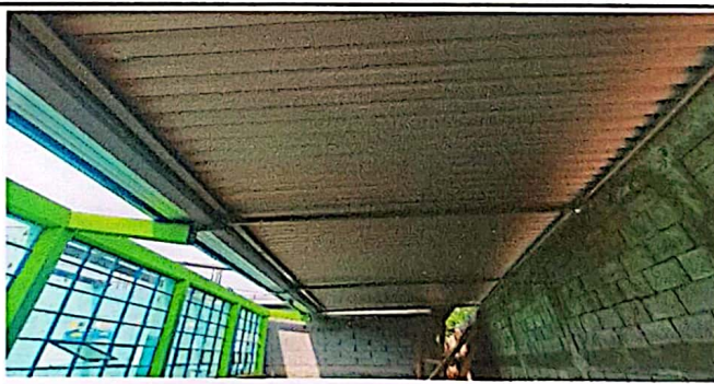
Foto 6: Mantenimiento a estructura metal (Canales, fijaciones e instalacion de cableado electrico)
