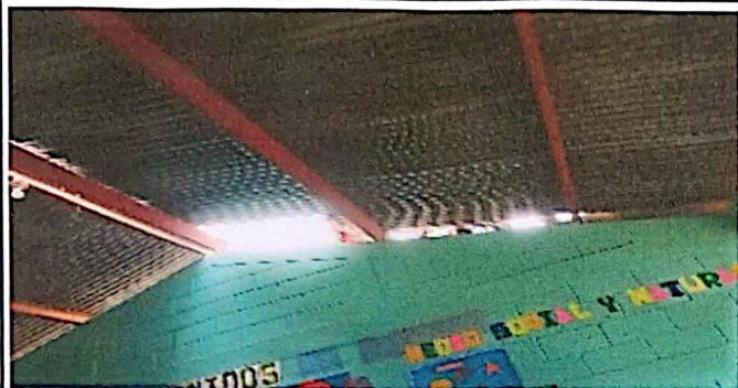
Foto 1: Mantenimiento a estructura (Sustracción de la lámina dañada y lijada de costaneras)
