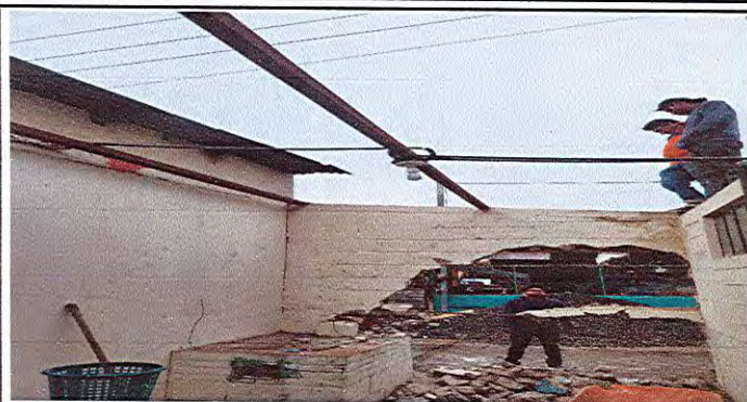
Foto 1: CUBIERTA DE LAMINA. SUSTITUCIÓN DE LÁMINA, POR LAMINA TROQUELADA ALUZINC C-26.
