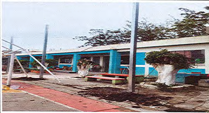
Foto 7: SUSTITUCIÓN DE PISO CERAMICO.
