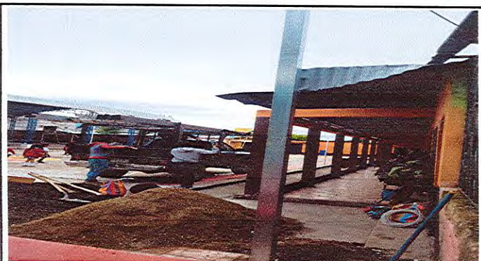
Foto 3: CANALES Y BAJADAS AGUA PLUVIAL. INSTALACIÓN DE CANAL DE METAL.
