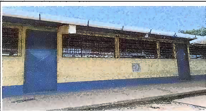
Modulo1: Sustitución de canal de pvc
