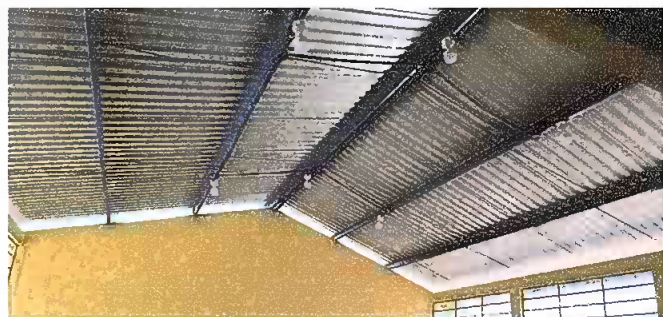
Modulo1: Mantenimiento a estructura de soporte de metal
