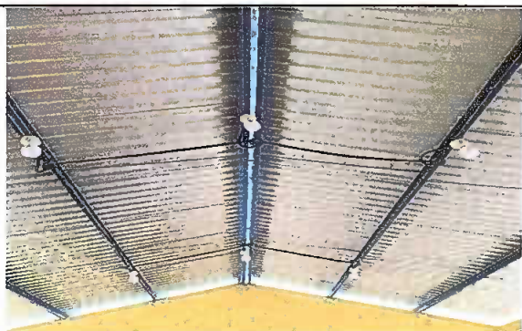
Modulo 1: Instalación de unidades luz (incluye interruptor, ducto y cable eléctrico)
