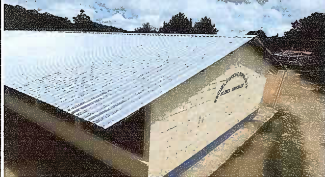
Modulo 1: Sustitución de lámina, por lámina troquelada aluzinc calibre 24
