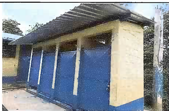
modulo 2: Sustitución de lámina, por lámina troquelada aluzinc calibre 24
