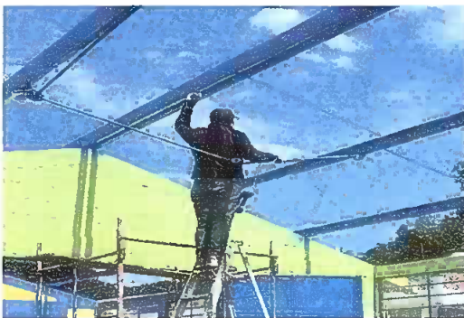
Modulo 1: Instalación de unidades luz (incluye interruptor, ducto y cable eléctrico)
