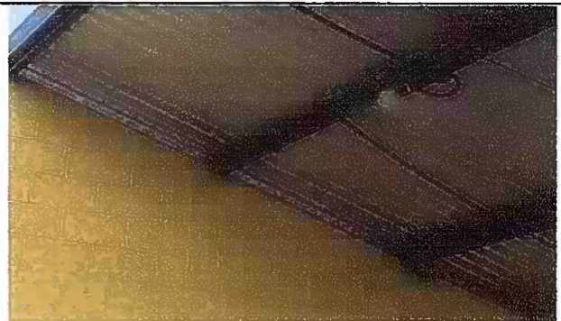
modulo 2: Sustitución de lámina, por lámina troquelada aluzinc calibre 24
