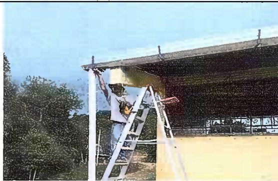
Modulo1: Sustitución de canal de pvc
