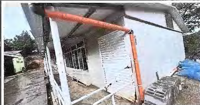
Foto 8. Modulo 3: Reparación de bajadas de agua pluvial, tubo PVC 3"
