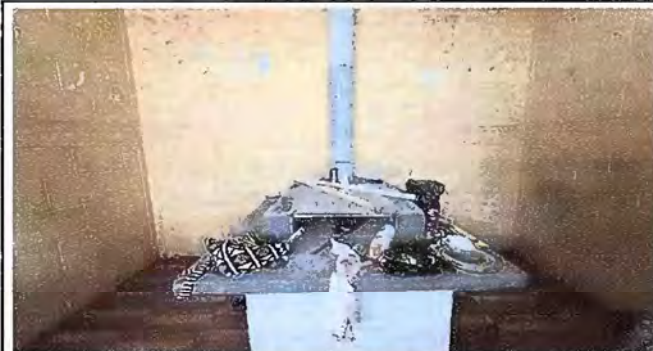
Foto 10. Modulo 4. Mantenimiento a estufa rural
