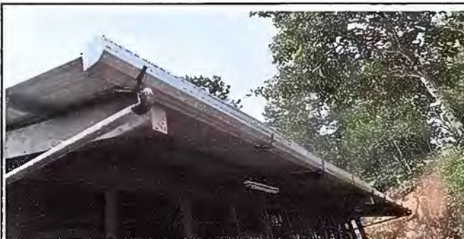
Foto 1. Modulo 1: Sustitucion de Canales de metal
