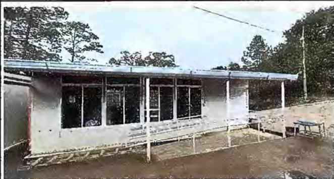
Foto 7. Modulo 3: Sustitucion de Canales de metal
