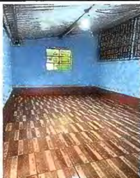
Foto 15. Modulo 5. Sustitucion de piso de torta de concreto, por piso ceramico
