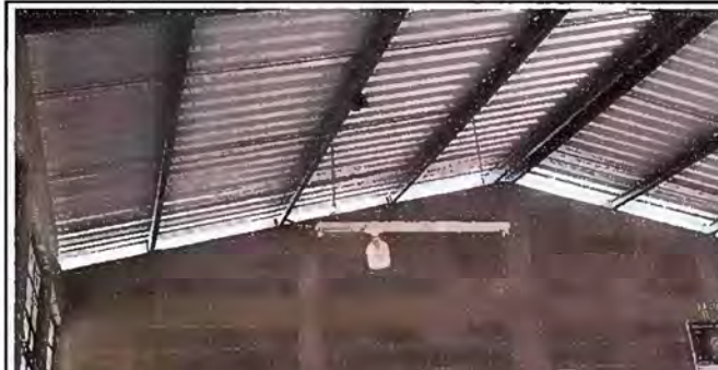
Foto 4. Modulo 1: Sustitucion de plafoneras
