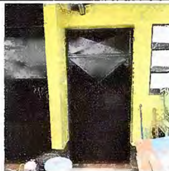
Foto 16. Modulo 5. Mantenimiento a estructura de puerta ( Lijado, pintado, cambio de tubos, sujeciones, cortado, y aplicación de pintura)
