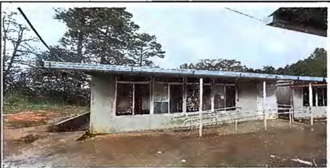
Foto 5. Modulo 2: Sustitucion de Canales de metal
