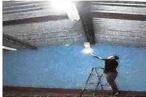
Foto 14. Modulo 4. Sustitucion de plafoneras
