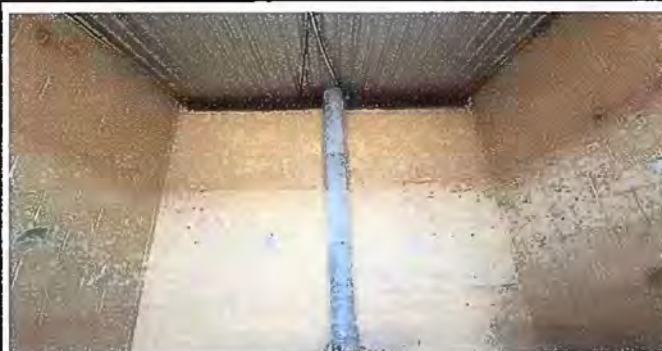
Foto 11. Modulo 4. Sustitucion de chimenea de metal por chimenea de concreto
