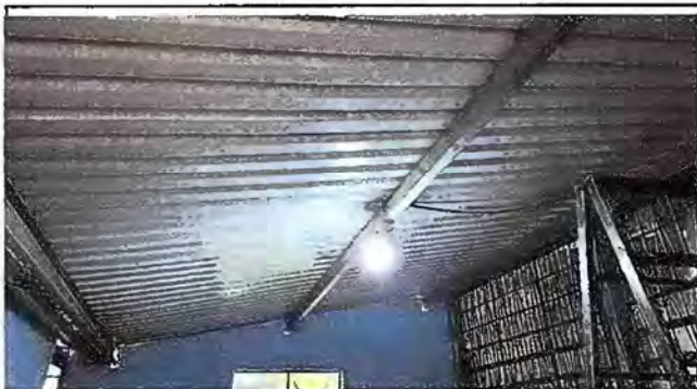
Foto 17. Modulo 5. Sustitucion de focos ahorradores
