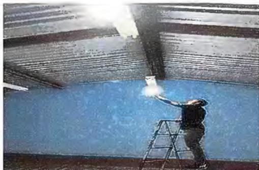
Foto 13. Modulo 4. Sustitucion de focos ahorradores
