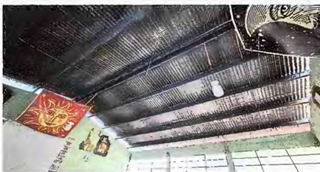
Foto 20. Modulo 6. Sustitucion de plafoneras
