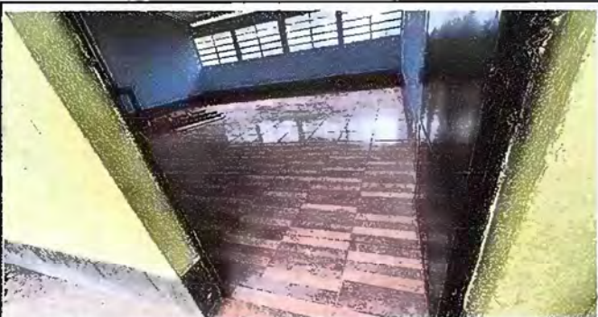
Foto 9. Modulo 4. Sustitucion de piso de torta de concreto, por piso ceramico:
