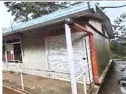
Foto 6. Modulo 2: Reparación de bajadas de agua pluvial, tubo PVC 3"
