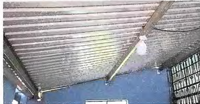
Foto 18. Modulo 5. Sustitucion de plafoneras
