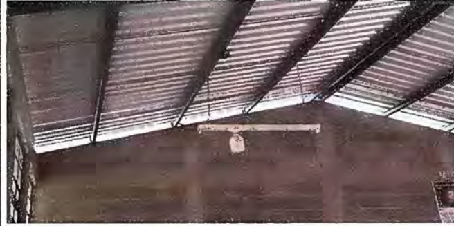
Foto 4. Modulo 1: Sustitucion de plafoneras
