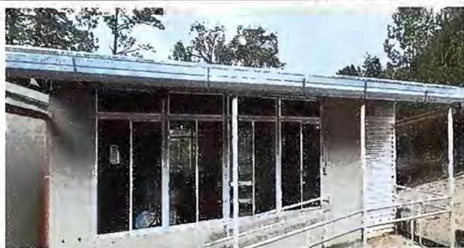
Foto 7. Módulo 3: Sustrucción de Canales de metal
