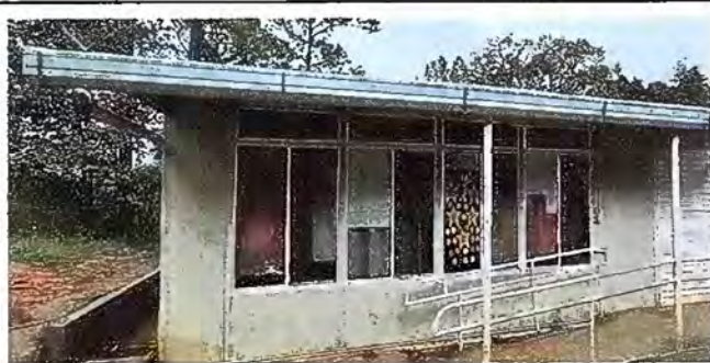
Foto 5. Modulo 2: Sustitucion de Canales de metal
