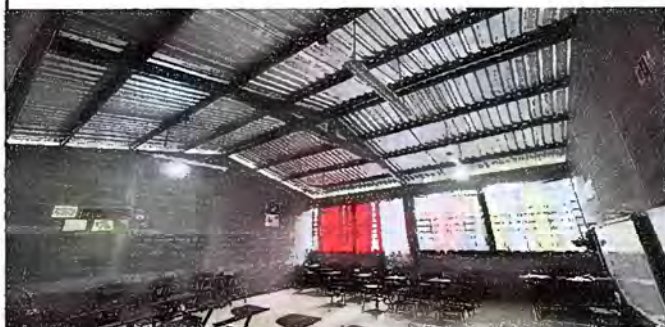
Foto 3. Modulo 1: Sustitucion de focos ahorradores
