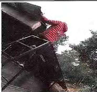
Foto 1. Modulo 1: Sustitucion de Canales de metal
