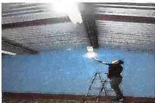
Foto 13. Modulo 4. Sustitucion de focos ahorradores
