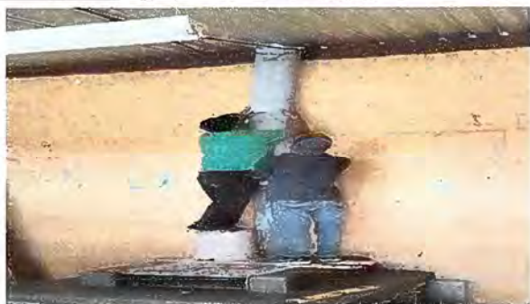
Foto 11. Módulo 4. Sustrucción de chimenea de metal por chimenea de concreto
