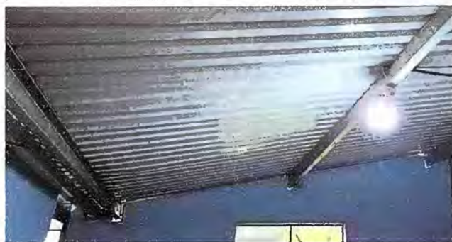
Foto 17. Modulo 5. Sustitucion de focos ahorradores
