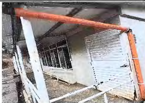
Foto 8. Módulo 3: Reparación de bajadas de agua pluvial, tubo PVC 3"
