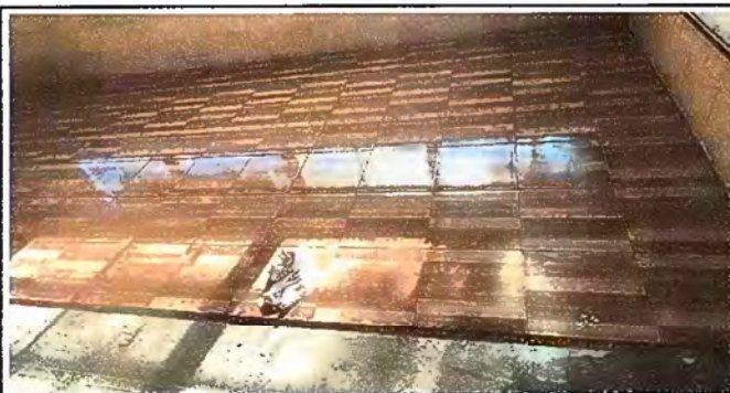
Foto 9. Módulo 4. Sustrucción de piso de torta de concreto, por piso cerámico:
