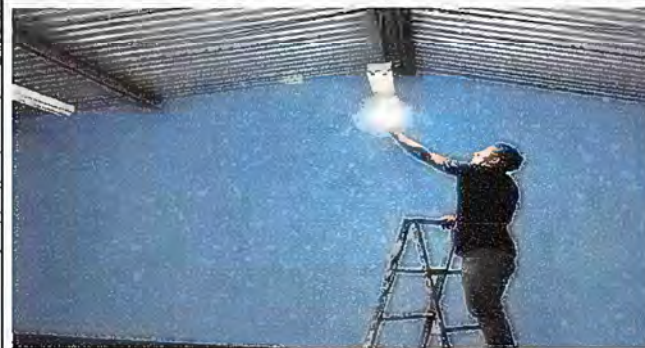
Foto 14. Modulo 4. Sustitucion de plafoneras
