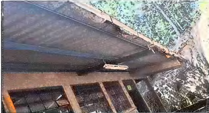
foto 1. Modulo 1: Sustitucion de Canales de metal
