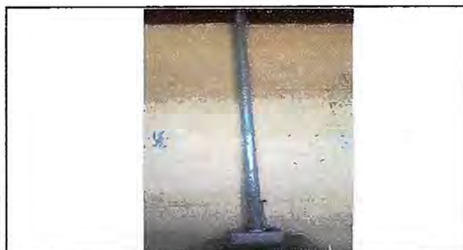
Foto 11. Módulo 4. Sustrución de chimenea de metal por chimenea de concreto
