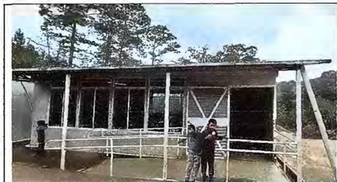
Foto 7. Módulo 3: Sustrución de Canales de metal
