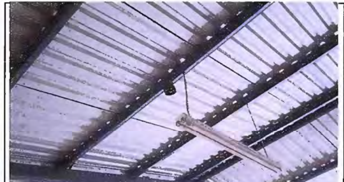
Foto 4. Modulo 1: Sustitucion de plafoneras
