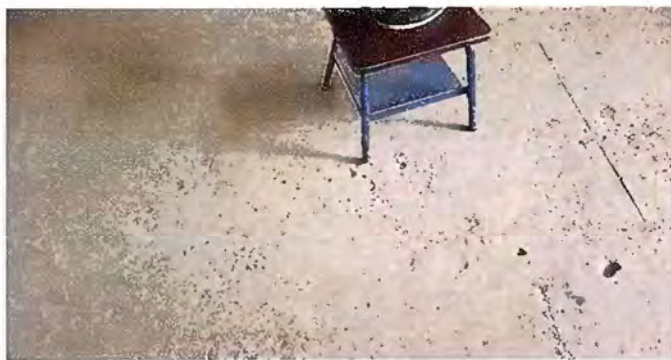
Foto 15. Modulo 5. Sustitucion de piso de torta de concreto, por piso ceramico
