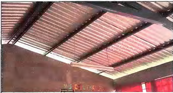
Foto 3. Modulo 1: Sustitucion de focos ahorradores
