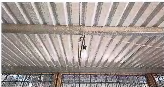
Foto 17. Modulo 5. Sustitucion de focos ahorradores
