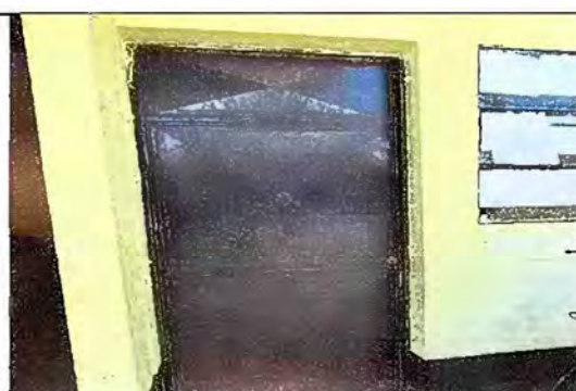
Foto 16. Modulo 5. Mantenimiento a estructura de puerta (Lijado, pintado, cambio de tubos, sujeciones, cortado, y aplicacion de pintura)
