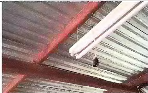
Foto 14. Modulo 4. Sustitucion de plafoneras
