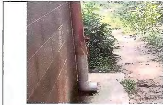
foto 2. Modulo 1: Reparación de bajadas de agua pluvial, tubo PVC 3"
