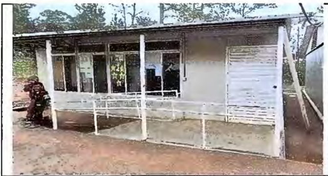
Foto 5. Modulo 2: Sustitucion de Canales de metal
