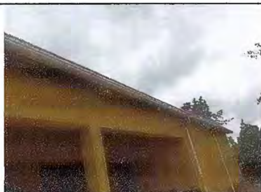
Foto 3. Módulo 1: Sustitución de canal de PVC, pescante y bajada de agua
