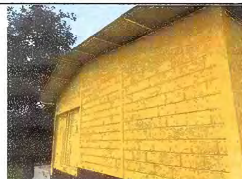
Foto 6. Módulo 1: Levantado de mojinete, altura 0.40 m
