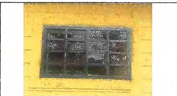
Foto 12. Módulo 2: Sustitución de ventana
