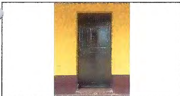
Foto 11. Módulo 2: Sustitución de puerta
