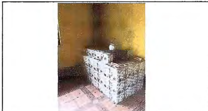
Foto 9. Módulo 2: Instalación de azulejo en estufa rural y piso cerámico en suelo.
