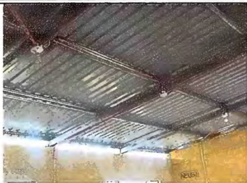
Foto 1. Módulo 1: Sustitución de estructura de soporte de madera por metal.
