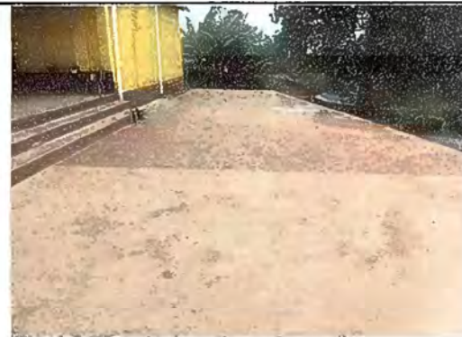
Foto 14. Patio: Sustitución de torta de concreto
