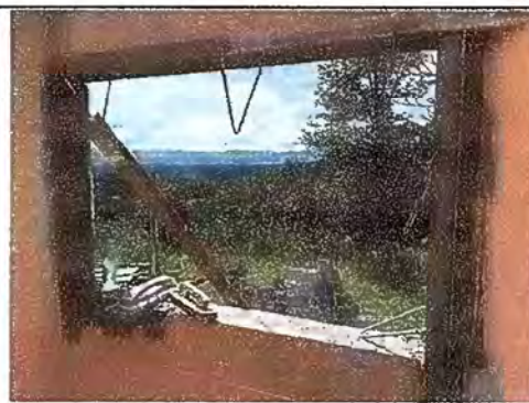
Foto 12. Módulo 2: Sustrucción de ventana
