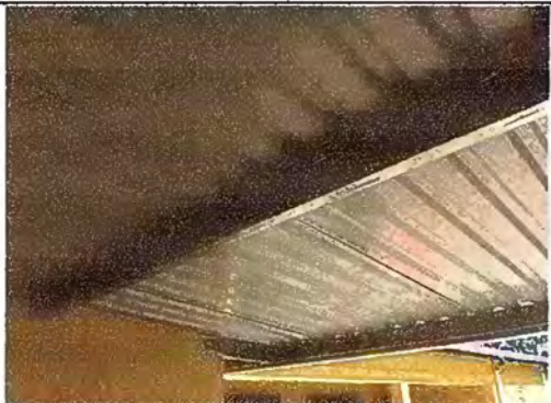
Foto 7. Módulo 2: Sustrucción de estructura de soporte de madera por metal y Sustrucción de lámina por lámina troquelada aluzinc calibre 26
