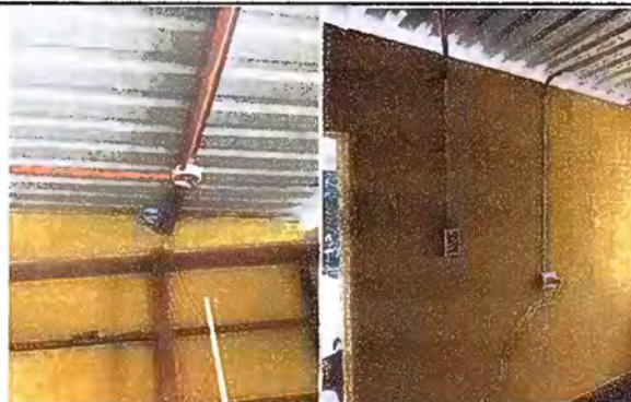
Foto 8. Módulo 2: Reparación del cableado eléctrico, sustrucción de interruptores y sustrucción de tocarrientes.
