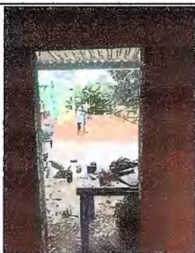
Foto 11. Módulo 2: Sustrucción de puerta
