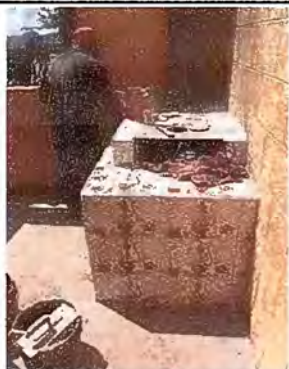
Foto 9. Módulo 2: Instalación de azulejo en estufa rural
