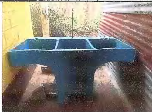
Foto 10. Módulo 2: Sustrucción de pila de cemento de dos lavaderos
