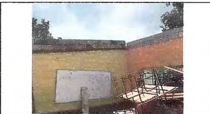
Foto 6. Módulo 1: Levantado de mojinete, altura 0.40 m
