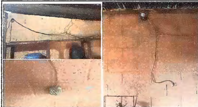
Foto 8. Módulo 2: Reparación del cableado eléctrico, sustitución de interruptores y sustitución de tocarrientes.
