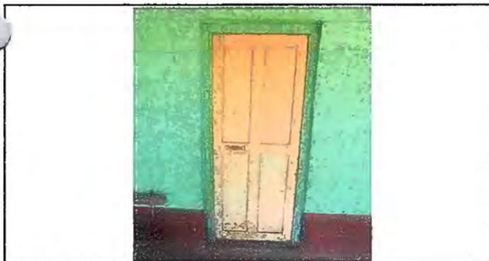
Foto 11. Módulo 2: Sustitución de puerta
