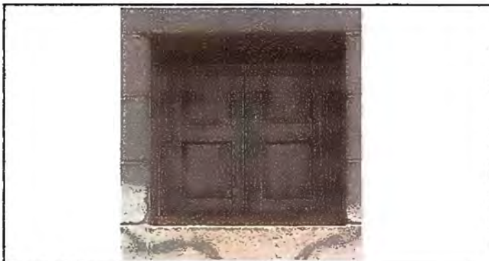
Foto 12. Módulo 2: Sustitución de ventana
