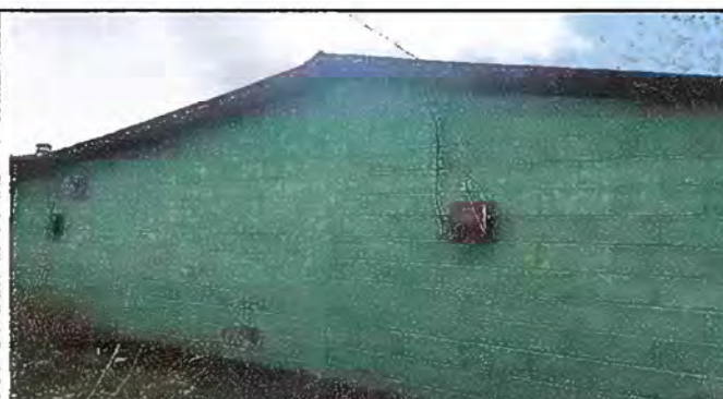
Foto 6. Módulo 1: Levantado de mojinete, altura 0.40 m
