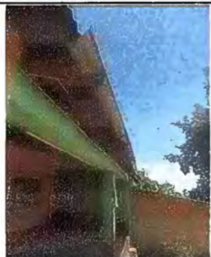
Foto 3. Módulo 1: Sustitución de canal de PVC, pescante y bajada de agua
