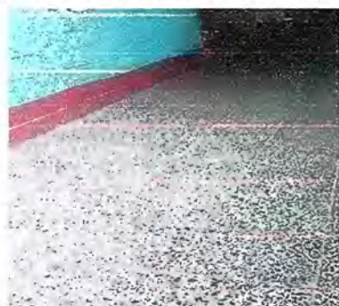
MODULO 2: FOTO. 5 REPARACION DE PISO DE TORTA CONCRETO A PISO GRANITO
