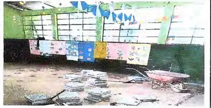
Foto 6: Sustrucción de piso de granito.
