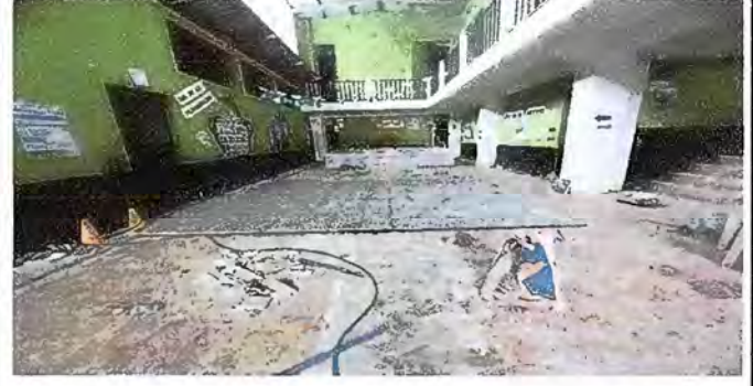
Foto 4: Sustrucción de piso de granito.
