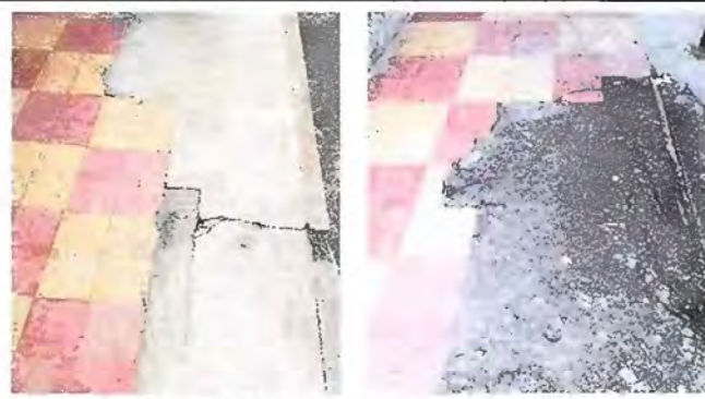
Foto 2: MODULO 1 SUSTITUCIÓN DE PISO POR PISO DE GRANITO..
