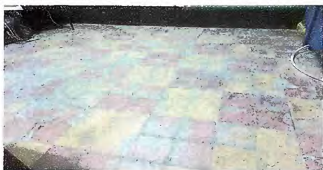
Foto 5: MODULO 1 SUSTITUCIÓN DE PISO POR PISO DE GRANITO.
