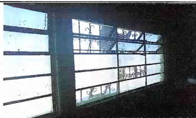
foto 2. Modulo 1: Ssustitucion de vidrios
