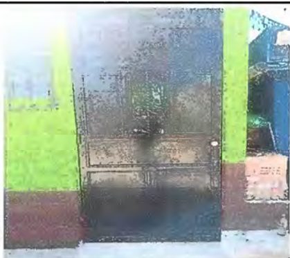
Foto 3. Modulo 1: Sustitución de puerta
