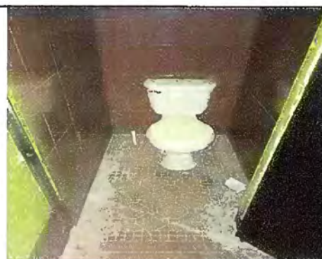
Foto 6. Modulo 1: Sustitucion de inodoro
