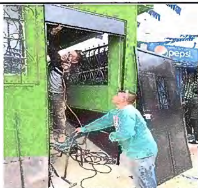
Foto 3. Modulo 1: Sustitución de puerta
