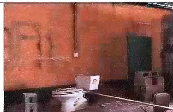
Foto 6. Modulo 1: Sustitucion de inodoro
