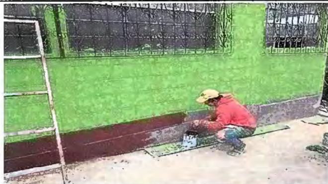
foto 1. Modulo 1: Pintura de paredes interiores y exteriores
