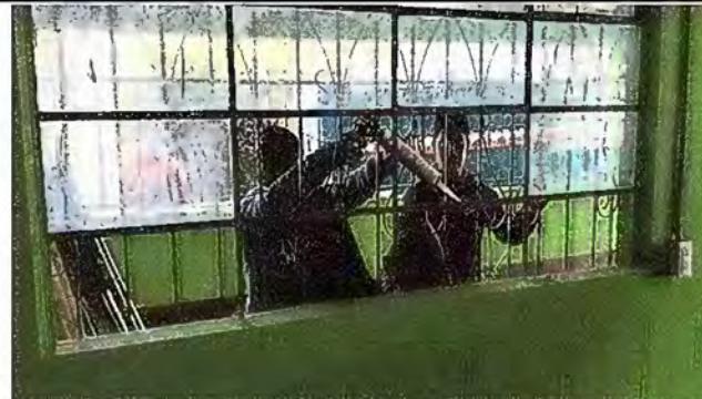
foto 2. Modulo 1: Ssustitucion de vidrios
