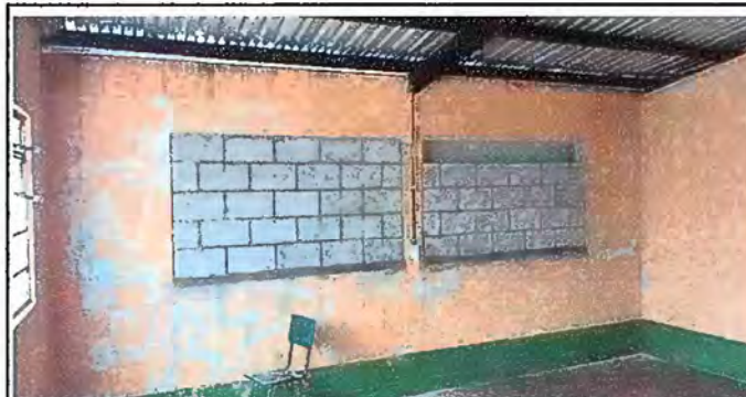
Foto 4. Modulo 1: reparacion de pared de block
