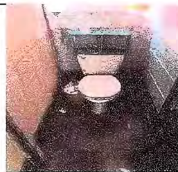
Foto 6. Modulo 1: Sustitucion de inodoro
