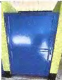
Foto 8. Módulo 1: Sustitución de puerta
