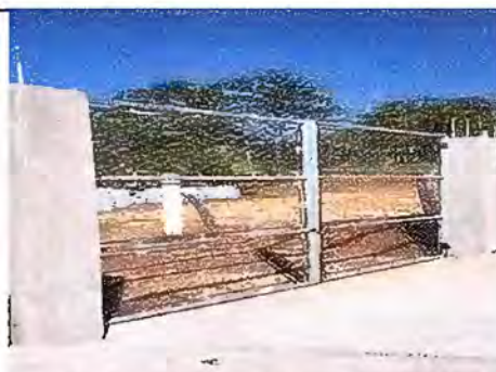
Foto 16. Modulo 4: Mantenimiento a porton de metal
