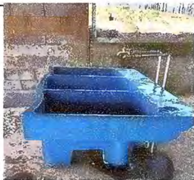
Foto 13. Modulo 2: Sustitución de pila de cemento de dos lavaderos
