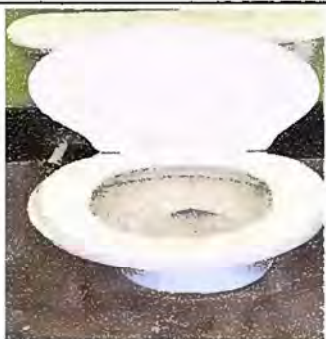
Foto 7. Módulo 1: Sustitución inodoro
