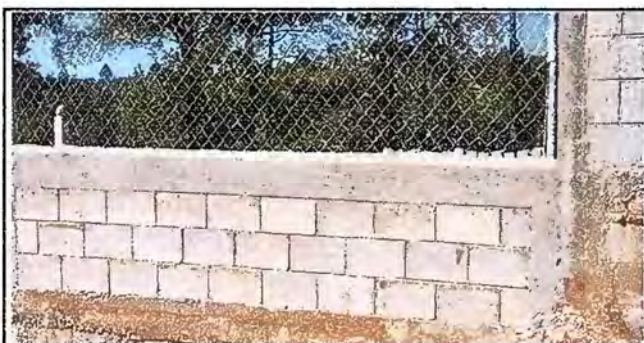
Foto 15. Modulo 4: reparacion de muro de block
