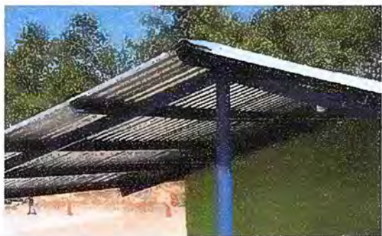
Foto 3. Modulo 1: Sustitución de capote para lamina troquelada
