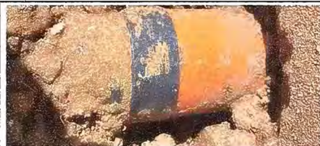
Foto 6. Modulo 1 Sustitucion de tuverla de pvc línea principal de aguas negras
