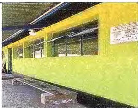
Foto 11. Módulo 2: Pintura de paredes interiores y exteriores
