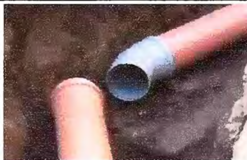
Foto 6. Modulo 1 Sustitución de tubería de pvc línea principal de aguas negras
