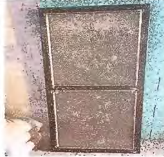
Foto 8. Módulo 1: Sustitución de puerta
