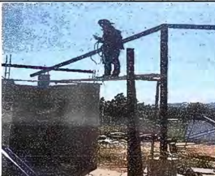
Foto 4. Modulo 1: Sustitución de estructura de soporte de madera, por metal
