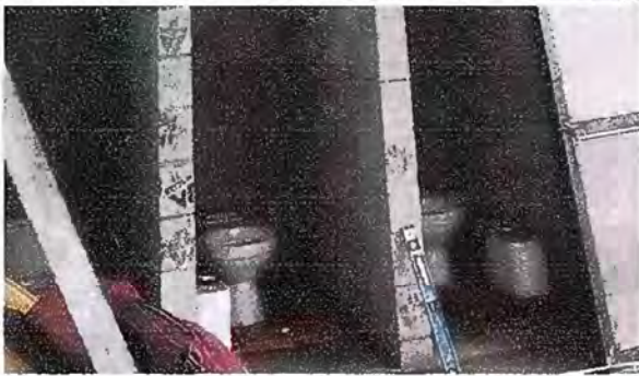
Foto 7. Módulo 1: Sustitución inodoro
