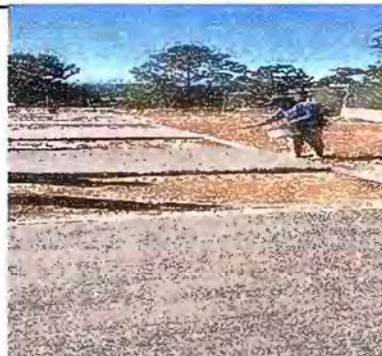
Foto 14. Modulo 3 :Reparacion de planchas de concreto de patio
