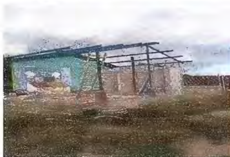
foto 1. Modulo 1: Sustitución de lámina por lámina troquelada aluzinc calibre 26
