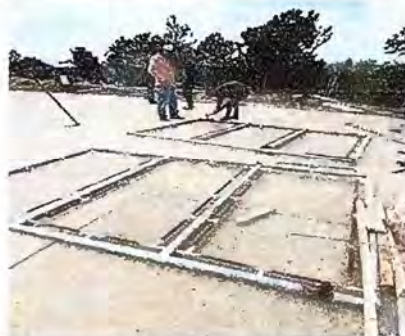
Foto 16. Modulo 4: Mantenimiento a porton de metal
