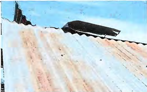
Foto 3. Modulo 1: Sustitución de capote para lamina troquelada
