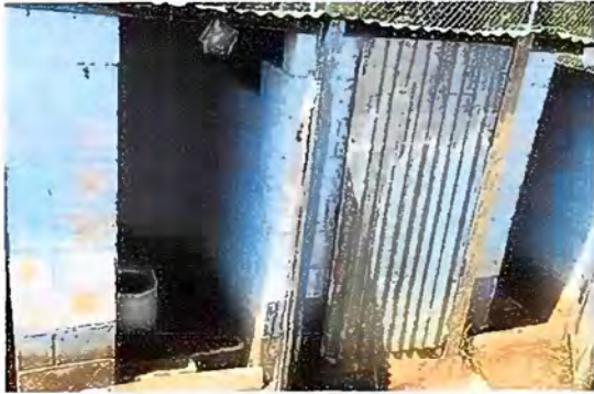
foto 1. Modulo 1: Sustitución de lámina por lamina troquelada aluzinc calibre 26
