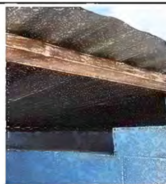
Foto 4. Modulo 1: Sustitucion de estructura de soporte de madera, por metal
