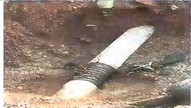
Foto 6. Modulo 1 Sustitucion de tuveria de pvc línea principal de aguas negras
