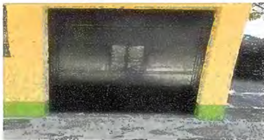
Mantenimiento a estructura de puerta (lijado, , cepillado, sujeciones, aplicación de pintura)
