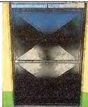
Mantenimiento a estructura de puerta (lijado, cepillado, sujeciones, aplicación de pintura)
