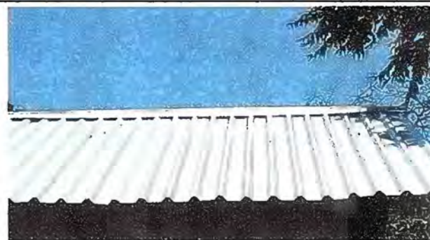
Sustitución de capote
