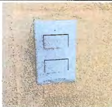
Sustitución de tomacorrientes dobles
