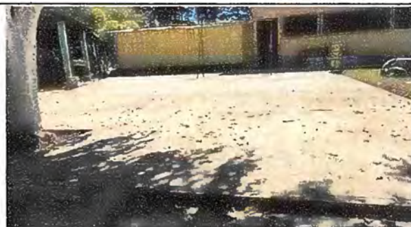
Reparación de planchas de concreto de patio
