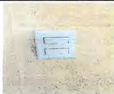
Foto 15. Modulo 3. Sustitución interruptores dobles
