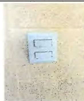
Sustitución interruptores dobles
