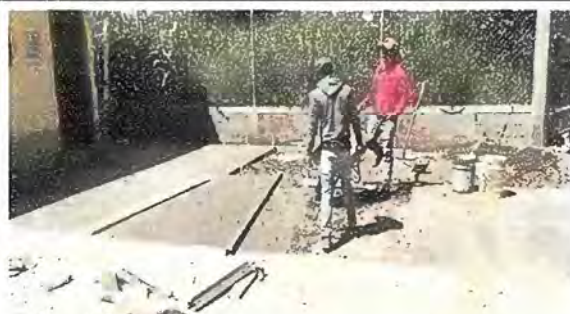
Foto 18. Patio No. 2. Reparación de planchas de concreto de patio
