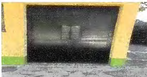
Foto 5. Modulo 1: Mantenimiento a estructura de puerta (lijado, , cepillado, sujeciones, aplicación de pintura)
