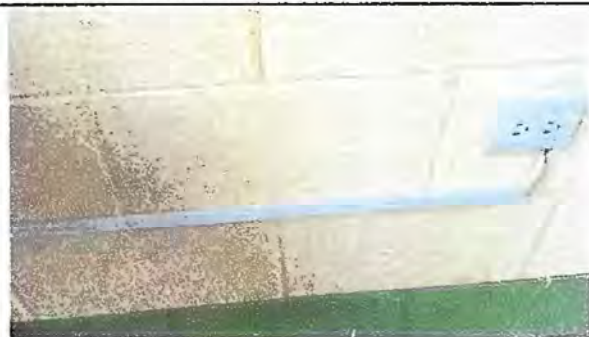
Sustitución de ducto eléctrico + accesorios (cable)
