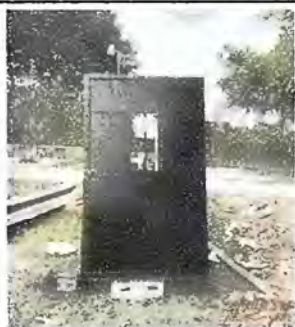
Foto 12. Modulo 3. Mantenimiento a estructura de puerta (lijado, , cepillado, sujeciones, aplicación de pintura)
