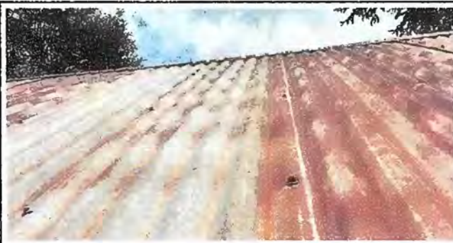
foto 2. Módulo 1: Sustitución de capote (maxalum calibre 26 para lamina troquelada)
