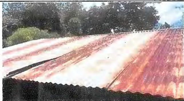
foto 1. Módulo 1: Sustitución de lámina por lamina troquelada aluzinc calibre 26
