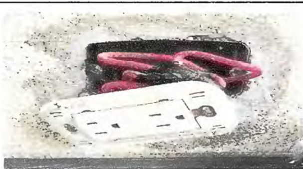
sustitucion de tomaacorrientes dobles
