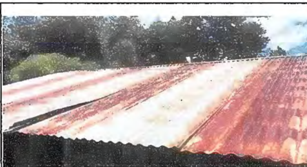
Foto 4. Módulo 1: desinstalacion de lamina existente
