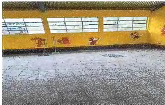
Foto 7: Módulo 3. Sustitución de piso de cemento líquido por piso granito.
