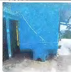
Foto 10: Módulo 3. Sustitución de pila de 2 lavaderos
