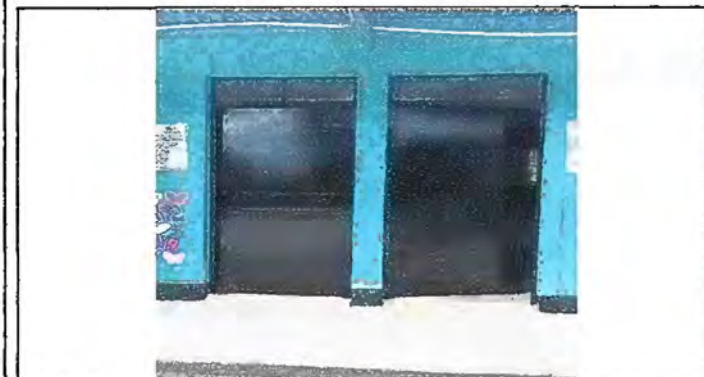
Foto 3: Módulo 1. Mantenimiento a estructura de puertas
