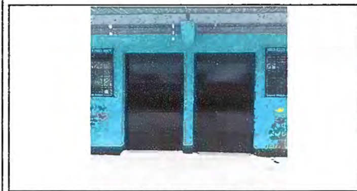
Foto 5: Módulo 3. Mantenimiento a estructura de puertas
