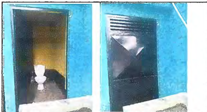
Foto 4: Módulo 2. Suministro e instalación de puertas en servicios sanitarios. Mantenimiento a puertas de servicios sanitarios.
