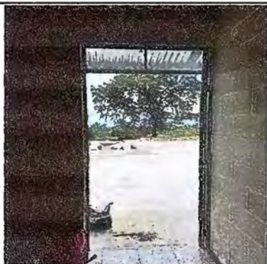
Foto 3: Módulo 1. Mantenimiento a estructura de puertas
