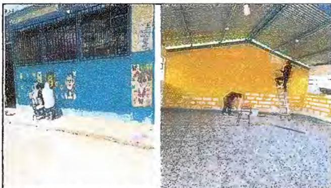
Foto 9: Pintura de muros interiores y exteriores
