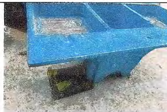
Foto 10: Módulo 3. Sustitución de pila de 2 lavaderos
