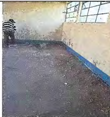
Foto 2: Módulo 1. Sustitución de piso de cemento líquido.
